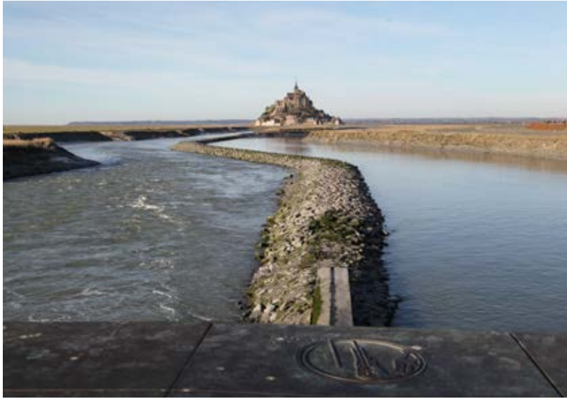
En aval du barrage, le Couesnon est séparé en deux bras. L'un permet de dégager le côté ouest du Mont, l'autre le côté est.
