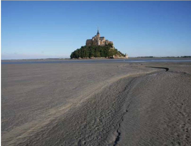
Vue prise du nord-ouest.
