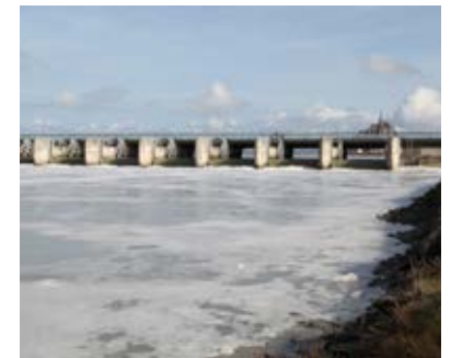
En amont du barrage, stockage de l'eau de mer dans le Couesnon pour provoquer ultérieurement une chasse.
