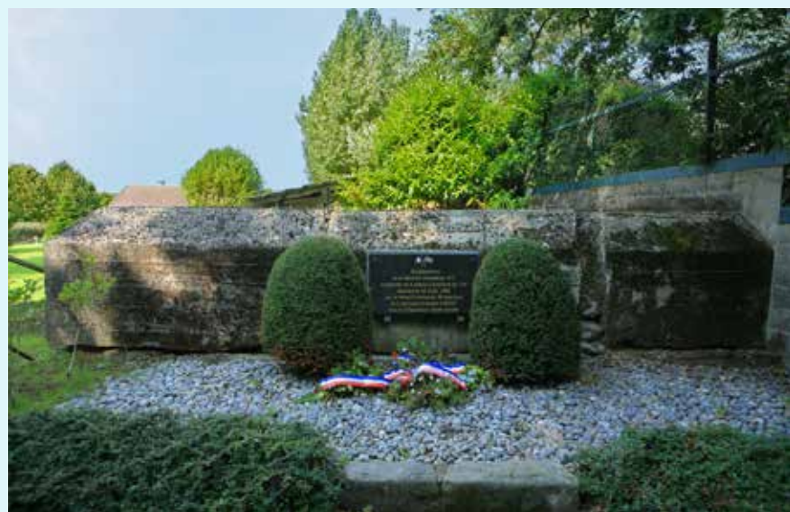
Sainte-Marguerite, blockhaus de la batterie 813.
